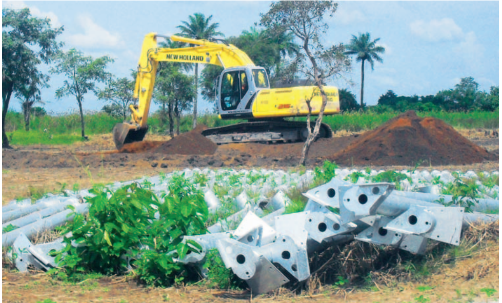
Construction du système d'irrigation de la plantation de canne à sucre
