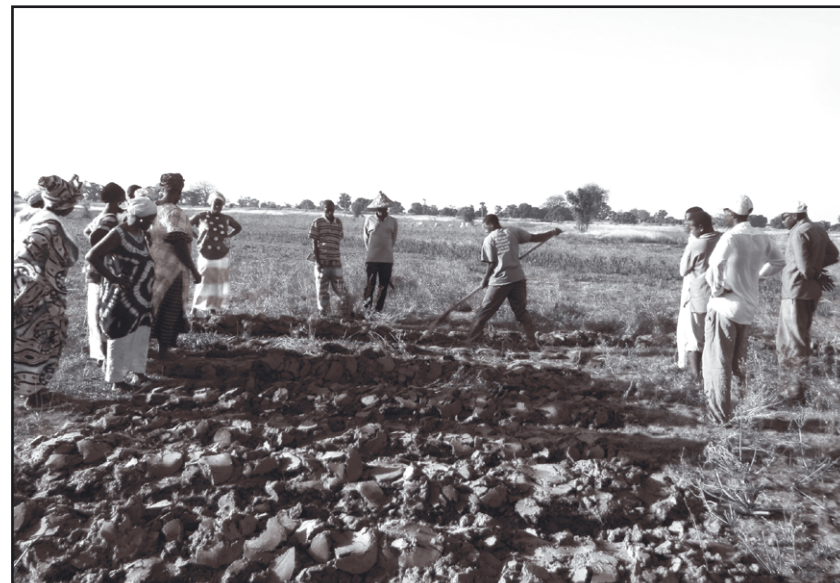
Chantier-école paysan dans la vallée du Dioural (groupement UCT), techniques de lutte contre la salinisation.
